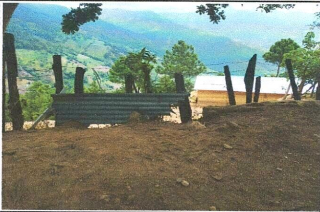
Foto 3: Mejoramiento de cercamiento perimetral
