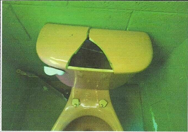
Foto1: Mejoramiento de servicios sanitarios
